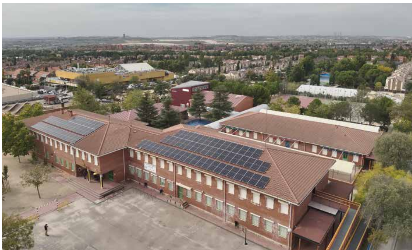
El colegio público Jarama será uno de los que se beneficie de la primera fase de climatización.
