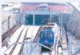
Desarrollo en trinchera del trazado de la Línea 9 de metro a su entrada en la estación de Rivas Urbanizaciones. 1999
