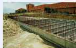
Proyecto y construcción del cubrimiento de vías en Rivas Urbanizaciones. Imagen de Covibar. 2000.
